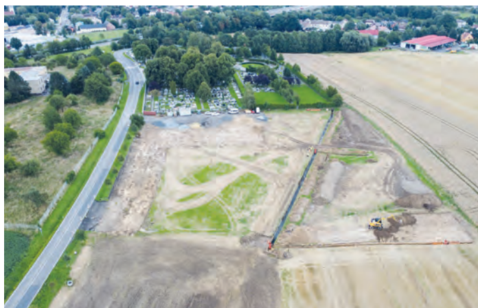
Pohled na místo, kde aktuálně probíhá výstavba porubského hřbitova.
