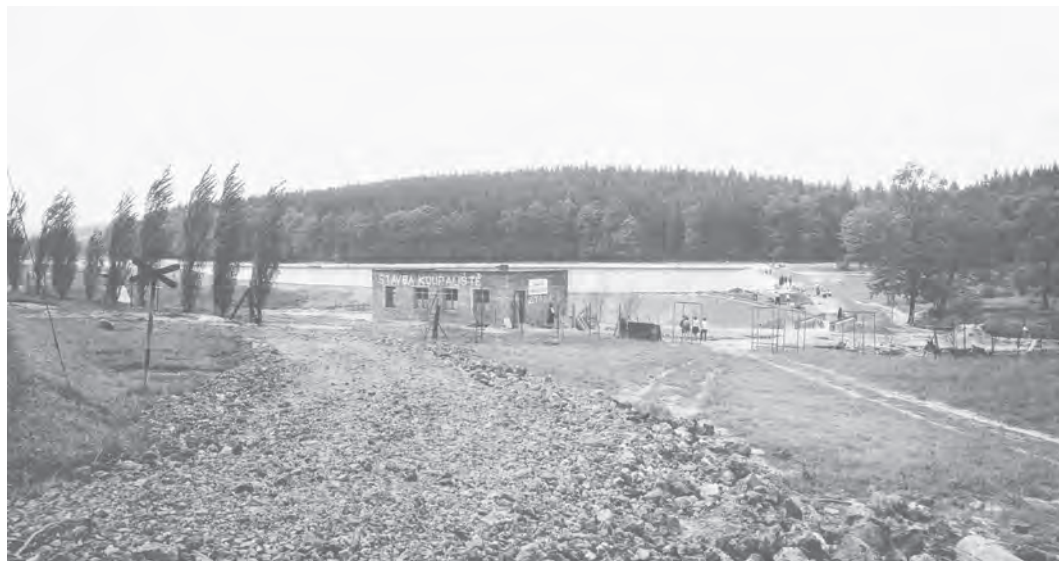
Stavba letního koupaliště byla zahájena v roce 1958.
