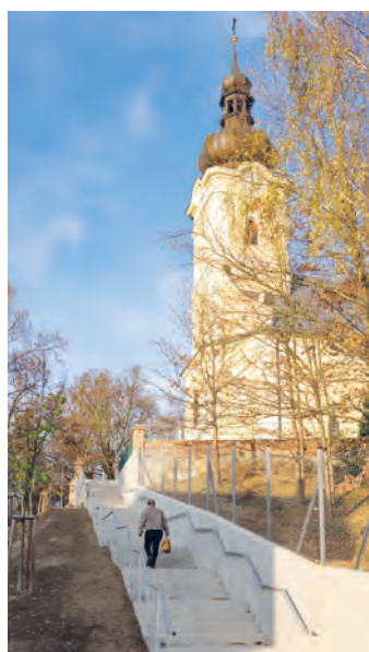
Opravené schody u kostela sv. Mikuláše
