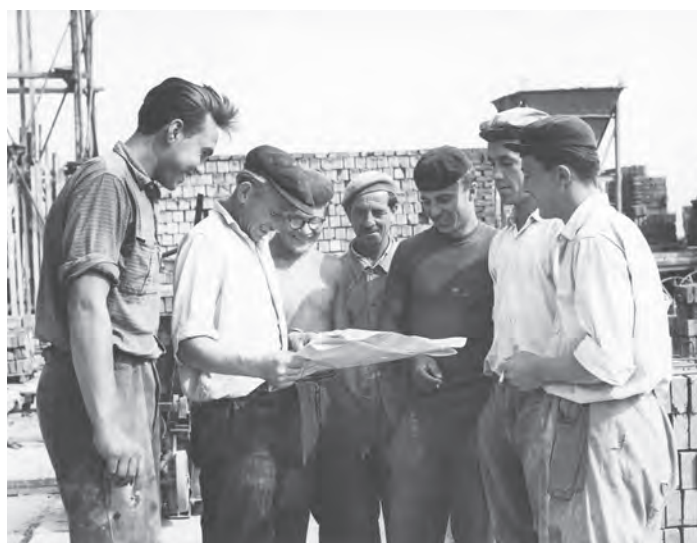
Stavbaři během výstavby Poruby
