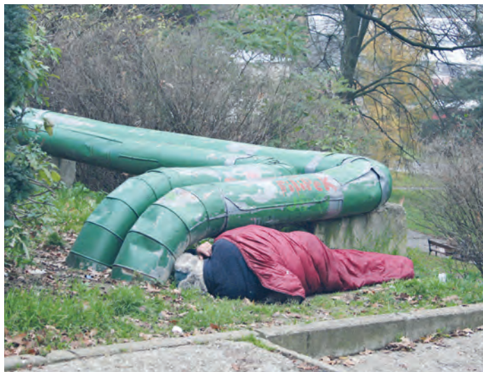
Místa, kde lze využít zdroj tepla, bezdomovcům vyhovují.
