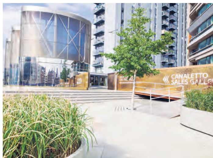
Administrativní budova v Londýně
