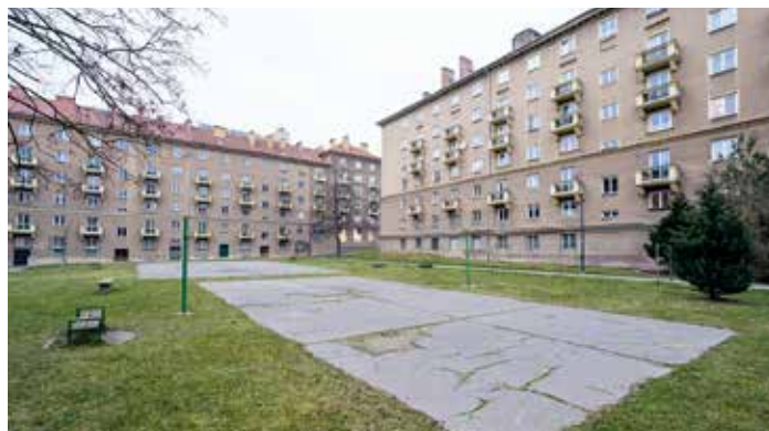
Ve dvoře u náměstí Boženy Němcové jsou dvě asfaltové plochy. Menší chce obvod odstranit a větší opravit.
