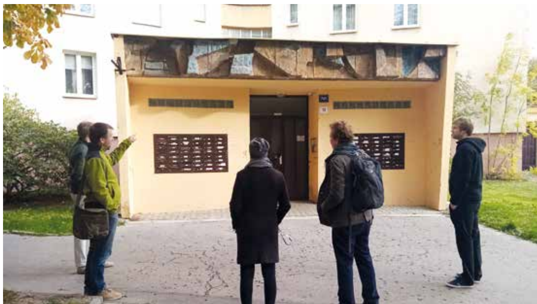
Kontrolní den při opravě reliéfu V dole nad vchodem do bytového domu Panorama na Havlíčkově náměstí. Foto: Pavlína Nováčková
