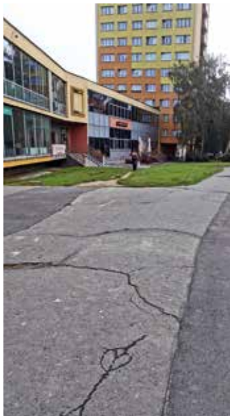
Předprostor Bohemie před rekonstrukcí...
