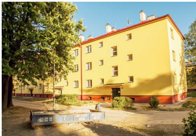
Opravený blok domů na Skautské ulici.
