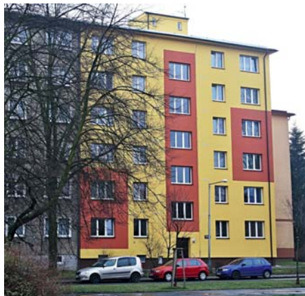
Domy v majetku městského obvodu se postupně opravují. Většina už má novou fasádu. Foto: Prokop Jirsák
