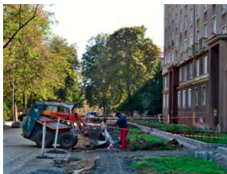
Práce na rekonstrukci ulice Matěje Kopeckého jsou v plném proudu.
