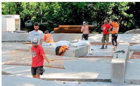
Rekonstrukce skateparku probíhala během prázdnin. Foto: Archiv
