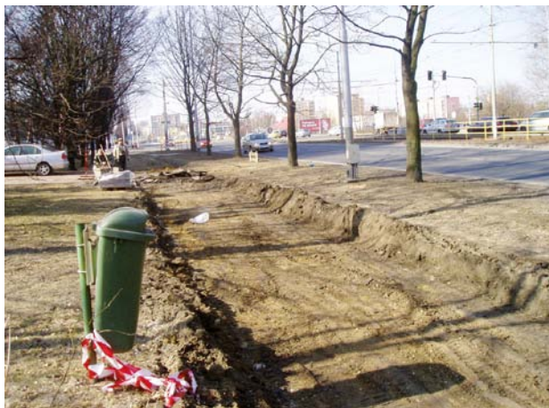
Nově budovaný úsek cyklostezky na Opavské ulici.
