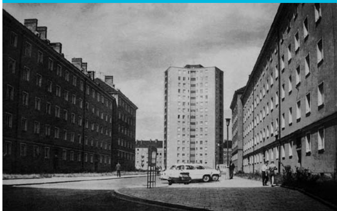
Havanská ulice v 60. letech 20. století a dnes.
