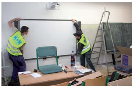
Instalace moderní techniky v ZŠ na Bulharské ulici. Foto: Michal Kačmařík
