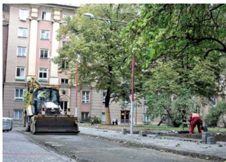
Stavební práce na náměstí Boženy Němcové. Foto: Michal Kačmařík
