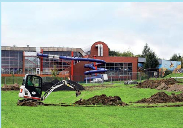
Stavební technika modeluje terén v blízkosti krytého bazénu. Foto: Michal Kačmařík
