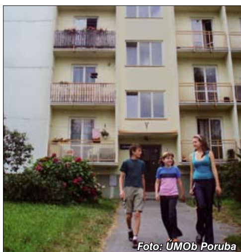
Dům s obecními byty na ulici Lvoňská, která je v Porubě oblíbenou lokalitou k bydlení.
