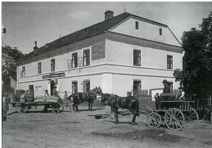
(správná budova podniku Velikosa s hostincem, zdroj: Archiv OÚ)
