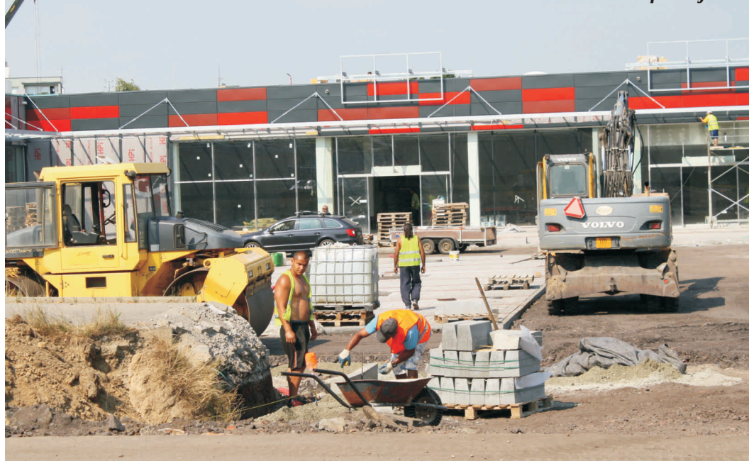
Stavba obchodního centra na Okružní finišuje...
