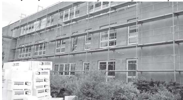
Okna na budovách základní školy U Studánky jsou vyměněna, začíná zateplování...
