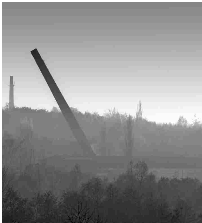
V neděli 6. listopadu byl v areálu Dolu Václav v Orlové-Porubě proveden odstřel komína bývalé kotelny. Po ukončení činnosti dolu byl areál dlouhodobě opuštěn a budovy v areálu začaly chátrat. Jejich stav byl v roce 2010 již havarijní, stavební úřad proto rozhodl o jejich odstranění, a to včetně odstranění osmdesátimetrového komína. Trhací práce - odstřel komínu pak povolil Obvodní báňský úřad v Ostravě. -HJ-
