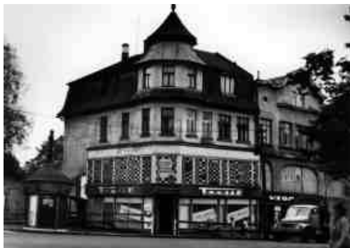
Původně textilní dům A. Wechsler v Orlové, vlevo kiosek s „věčným ohněm“ před demolicí. Zbouráno 1980.
