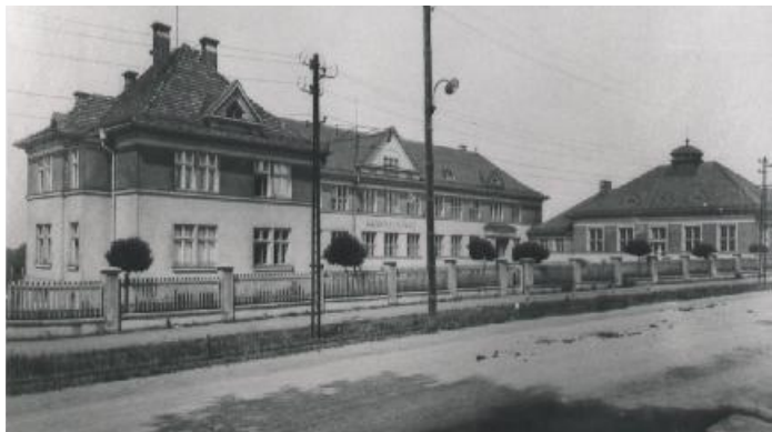
Základní (původně Masarykova měšťanská) škola v Orlově-Městě „Na Kopaninách“, zrušená v roce 1989. Snímek z první ČSR.
