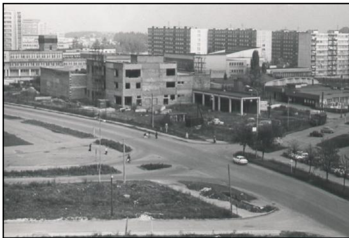
Definitivní sídlo orlovského Prioru ve výstavbě – psal se rok 1981.
