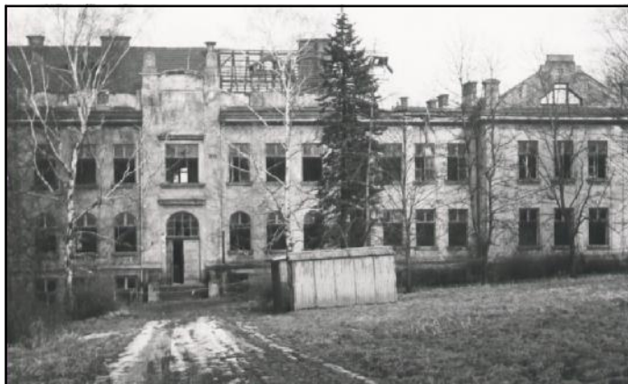
Demolice orlovského gymnázia v Orlové-Městě v roce 1980.
