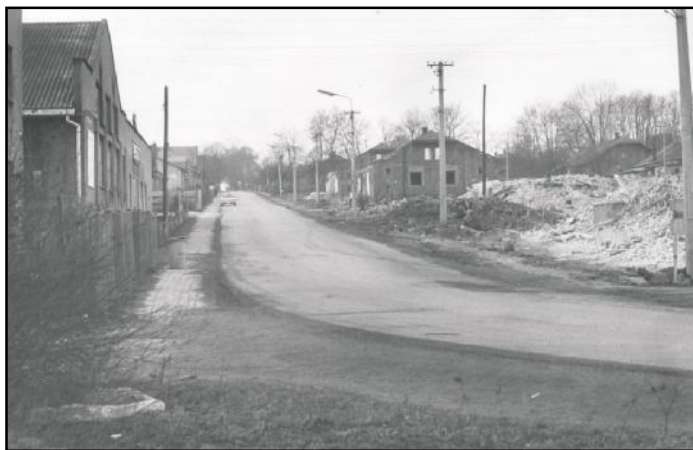
Rekonstrukce silnice přes Orlovou-Porubu podél Halfarovy kolonie. Snímek z konce roku 1983.
