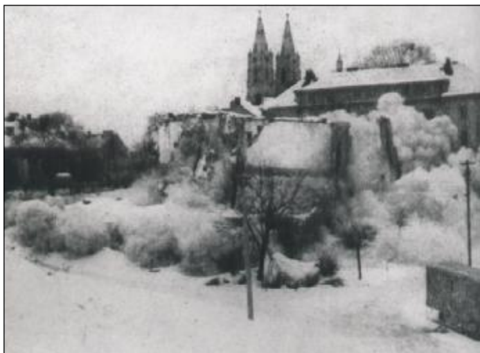
... a tohle z ní zbylo po odstřelu v roce 1969.
