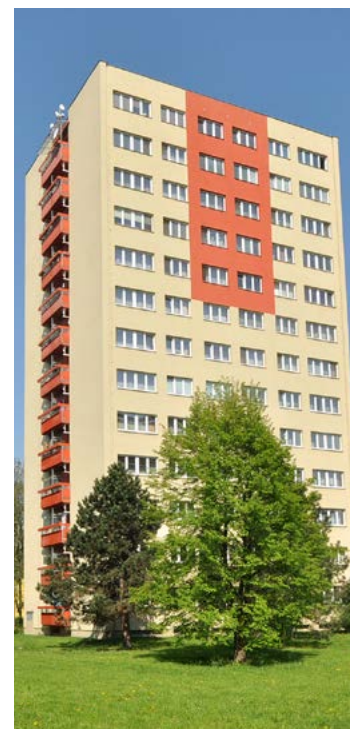
Ve věžovém domě v Nerudově 973 je k dispozici byt 2+1. Jeho prohlídky se konají 14. a 15. dubna, licitace proběhne 20. dubna.
