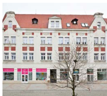
V historickém domě na třídě Dr. E. Beneše 109 se uvolnil byt 3+1. Zájemci si ho mohou prohlédnout 13. a 14. dubna a vylicitovat 15. dubna.
