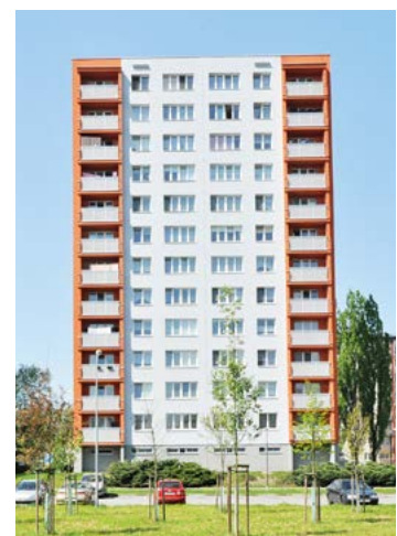
Ve věžovém domě v Tovární 426 je k dispozici prostorný byt 3+1. Jeho prohlídka se konají 30. a 31. března, licitace proběhne 8. dubna.
