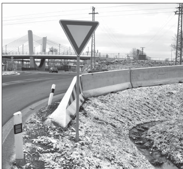
Jedny z »provizorních« betonových svodidel jsou u výjezdu z ulice Na Hrázi. Řidičům ztěžují výhled. Foto: Pavel Čempěl
