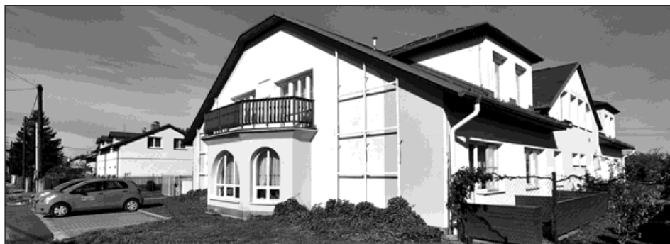
Dům Na Chalupách vyrostl v roce 1998 a v první fázi byl určen starým lidem, kteří přišli o střechu nad hlavou při povodni. Foto: Pavel Čempěl
