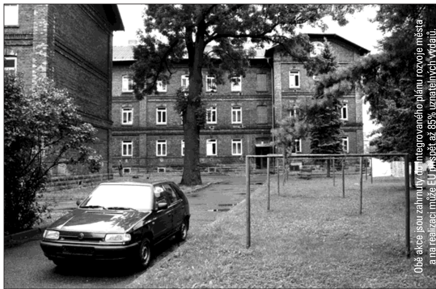
▲ Revitalizace dvora mezi ulicí Nádražní a 9. května řeší úpravu zelených ploch i parkování. Foto: Pavel Čempěl
