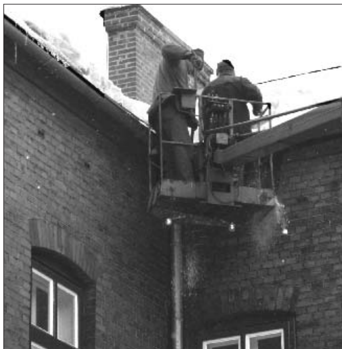
▲ Střechy jsou plné zmrzlého sněhu a rampouchů. Vytvářejí nebezpečí, které nelze podcenit. Majitelé domů zodpovídají za případné úrazy, způsobené neočekávaným pádem tvrdého ledu ze střechy.
