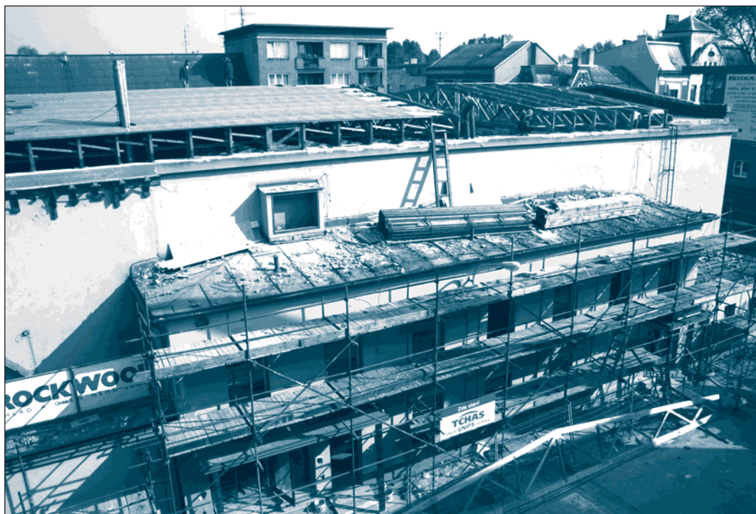
▲ Řemeslníci rozebírali starou střechu kina za pomoci jeřábu.
