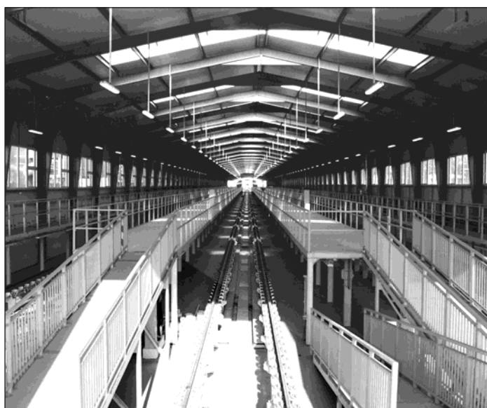
▲ Nová hala oprav technicko-hygienické údržby.
