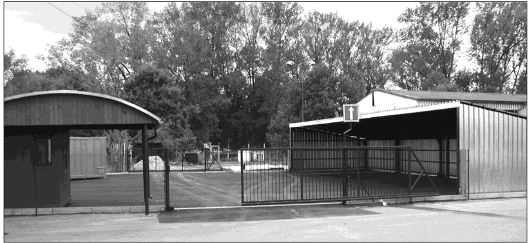
▲ Prostor nového sběrného dvora v areálu BM servisu, a. s.
