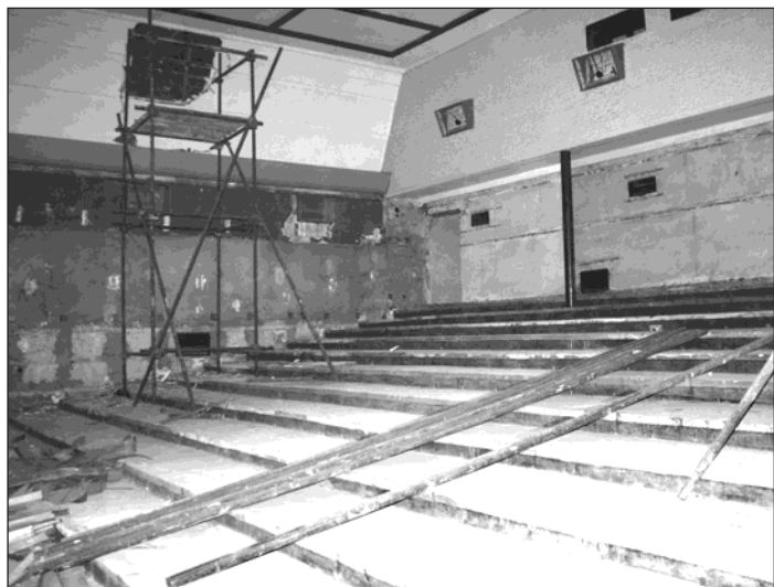
▲ V plném proudu je rekonstrukce bohumínského kina. Přestavba by měla být dokončena v prosinci letošního roku. Foto: František Krejček
