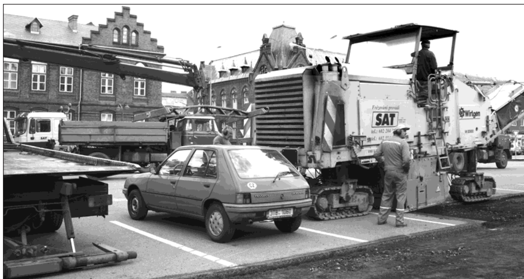
▲ Zaparkovaný osobní vůz neočekávaně zkomplikoval zahajovací práce na rekonstrukci náměstí T. G. Masaryka. Nakonec byl naložen a odvezen do areálu BM servisu. Foto: František Krejzek
