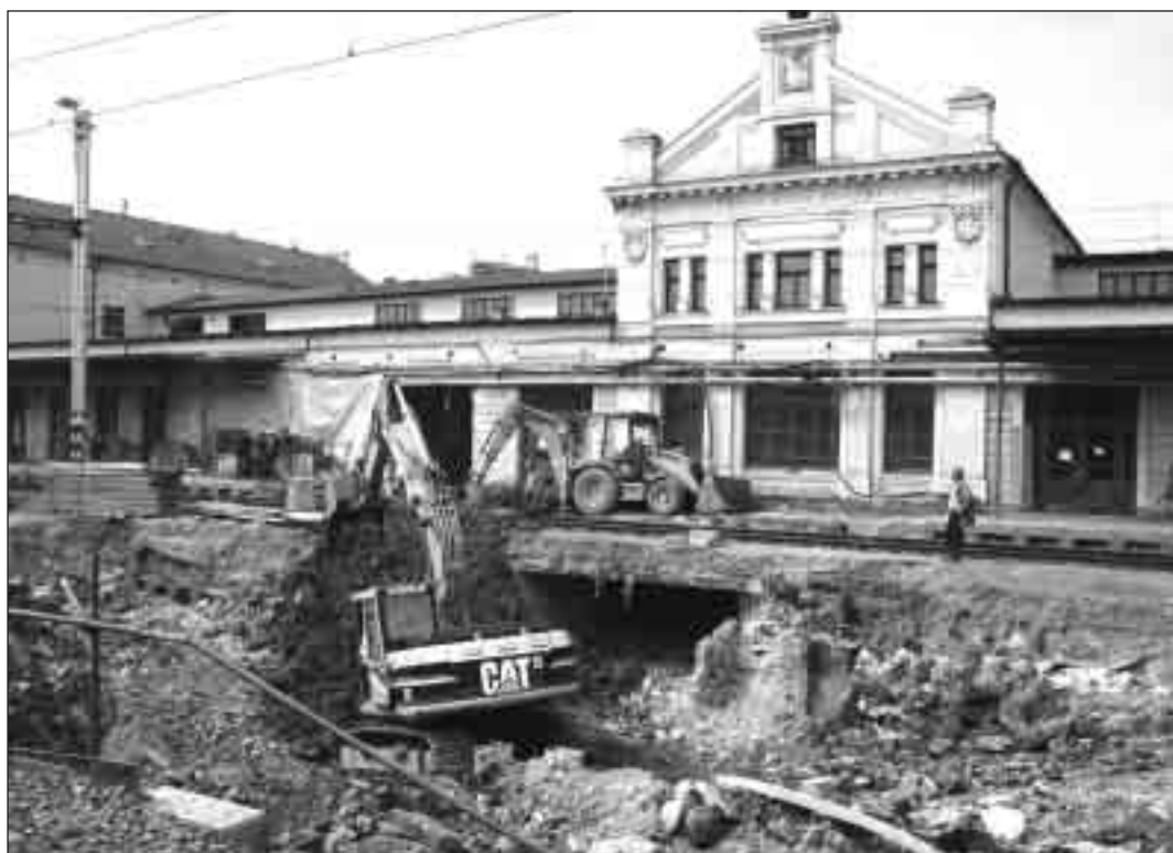
▲ Výkopové práce v samém středu nádraží se podepsaly na komplikovaném příchodu cestujících na nástupiště tři a čtyři. Dočasný přístup směrem na Ostravu se rozhodně nedá zařadit mezi pohodlné.
