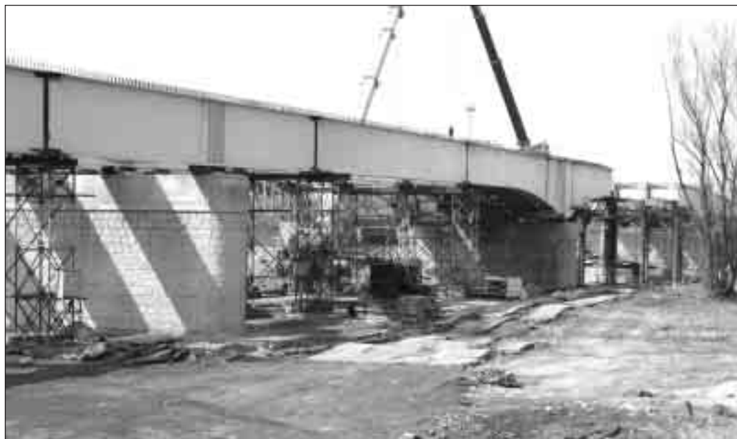
▲ Nový silniční most do Polska, který se staví mezi železničním a starým mostem ve Starém Bohumíně, zajistí větší propustnost silniční dopravy mezi dvěma státy Evropské unie (foto ze 14.4.2005).
