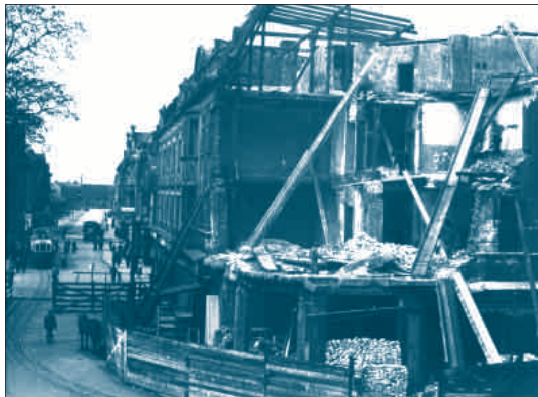
▲ Při náletu Američanů na Bohumín 29. srpna 1944 dostal přímý zásah i dům, který stál naproti nádražní budově - bomba jej doslova rozrazila. Foto archiv »Historický kufr«.
