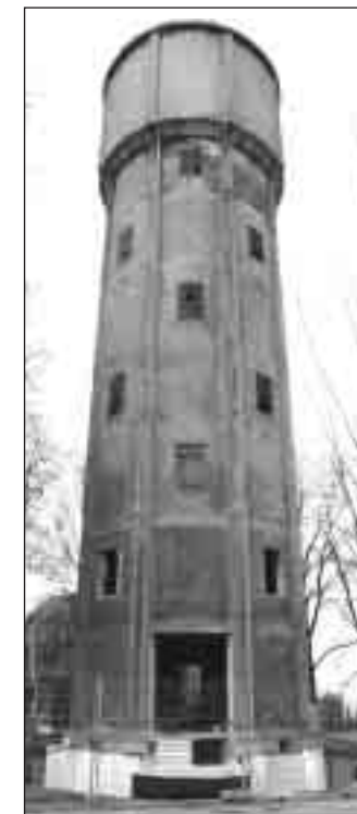
▲ Přestavba vodárenské věže na penzion s vyhlídkovou restaurací začala zpevněním základů konstrukce. Článek z bližšími informacemi najdete v příštím čísle našich novin.
