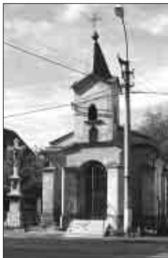
▲ Na dokončení opravy kaple v Záblatí schválilo zastupitelstvo města dotaci ve výši 80 tisíc korun. Oprava kaple proběhne velmi rychle. Již v den záblatské poutě 15. května 2005 se zde bude sloužit mše svatá, která kapličku znovu otevře. Škoda, že tuto hezkou sakrální stavbu hyzdí necitlivě umístěný sloup elektrického vedení.
