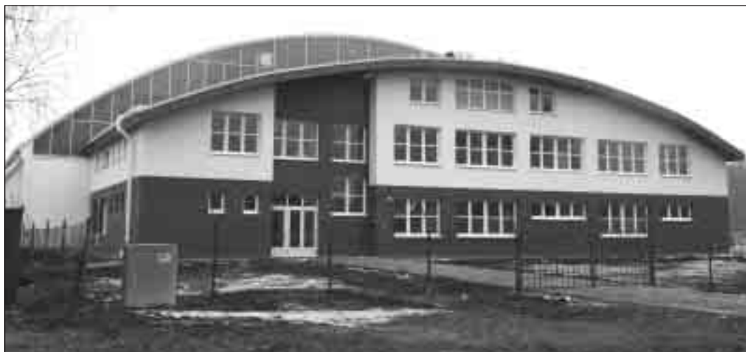
▲ Přístavba zimního stadionu, která byla dokončena v minulých dnech, rozšíří jeho služby o moderní zázemí včetně šaten, občerstvení a sociálního zařízení. Foto: Lucie Balcarová
