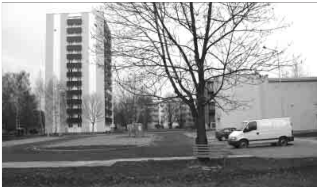
▲ Regenerace panelových sídlišť letos pokračuje výstavbou parkoviště u Sportcentra na Nerudově ulici. Vznikne zde 65 parkovacích míst. Náklady na výstavbu činí zhruba 5,6 milionu korun. Foto: F. Krejzek
