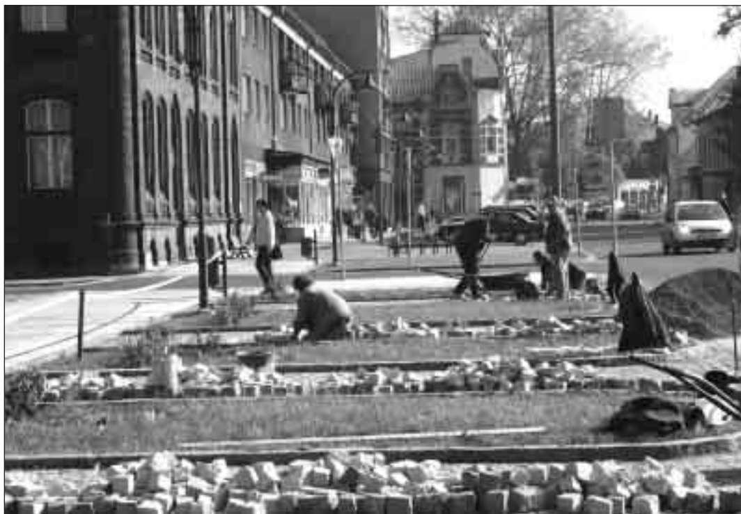
▲ Rozšířená parkovací stání před budovou radnice řidiči uvítají - do úzkých stanovišť se jim špatně zajiždělo.
