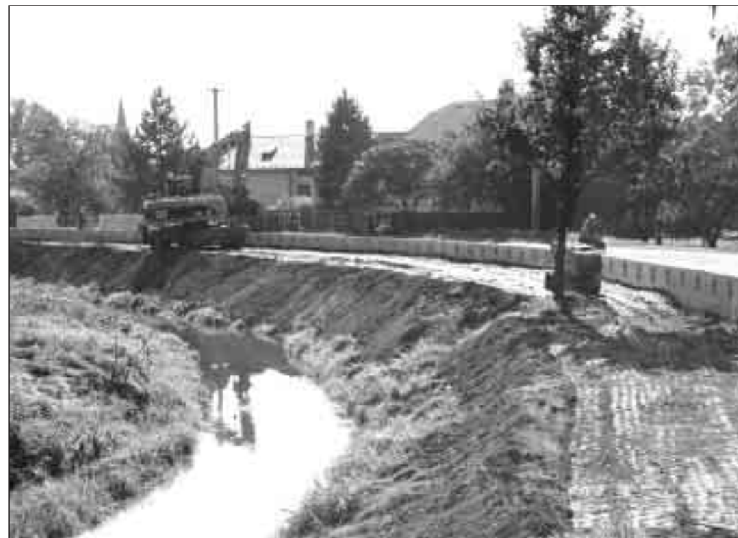
▲ V Šunychlu pokračuje výstavba protipovodňových hrází. Betonové panely zpevňující násep břehu zabrání rozlití Bohumínské stružky do okolí.
