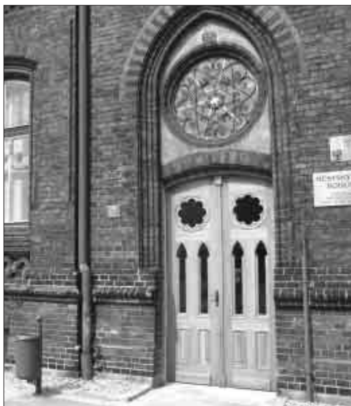
▲ Městský úřad rozšířil znovu své působení do budovy bývalé radnice. Při rekonstrukci přízemí byly na místo vstupu vsazeny repliky původních dveří, které se dochovaly pouze na dobových fotografiích.
