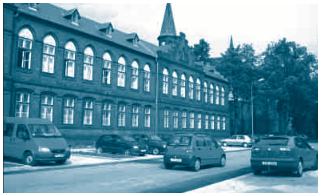
▲ Od 10. července slouží v centru města nové parkoviště s dvačtyřiceti podélnými i kolmými stáními.
