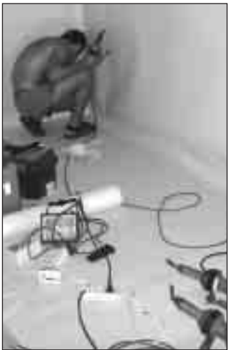
▲ Vyplastovaná akumulární jímka od 23. července znovu plní svou funkci rezervoáru pro cirkulaci vody v bazénu.
