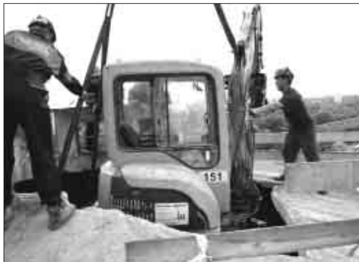
▲ Kruhovou betonovou nádrž uvnitř bývalé vodárenské věže bylo nutno rozbít pomocí těžké techniky. Střechou věže byl proto spuštěn dovnitř malý drtící stroj.
