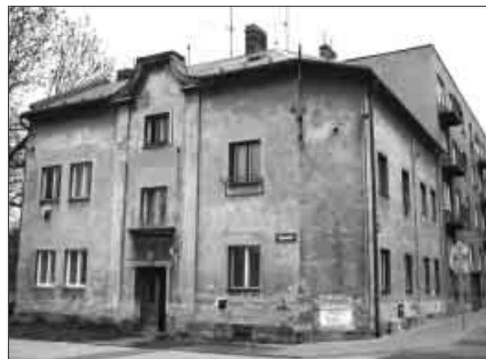
Z oprýskaného objektu, který dnes kazí hezký vzhled náměstí Budoucnosti, se stane po rekonstrukci dům s bytovými jednotkami první kategorie (Čáslavská čp. 268). Práce na opravách by měly být zahájeny v letošním roce.
