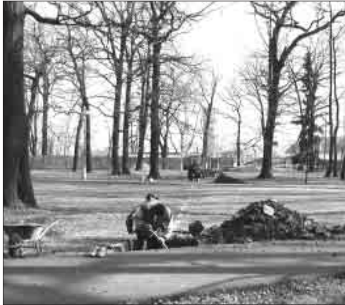
▲ Park Petra Bezruče protála přímka, která vyznačuje budoucí středotlakou přípojku plynovodu k plaveckému bazénu
