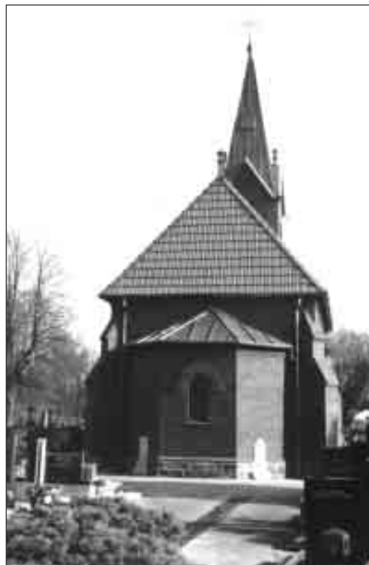
▲ ... a po opravě
