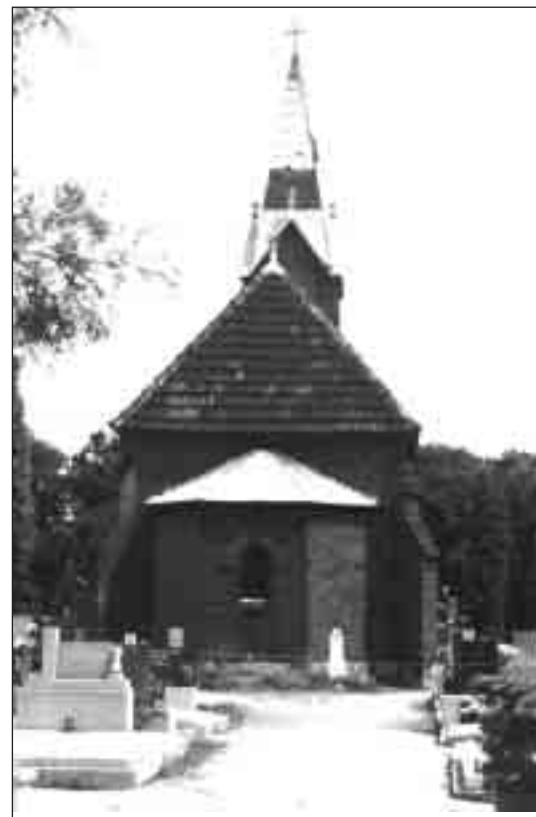
▲ Hřbitovní kaple ve Starém Bohumíně před opravou...
