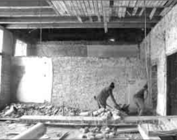
Z původní stavby zůstane jen obvodový plášť a vnitřní schodiště
