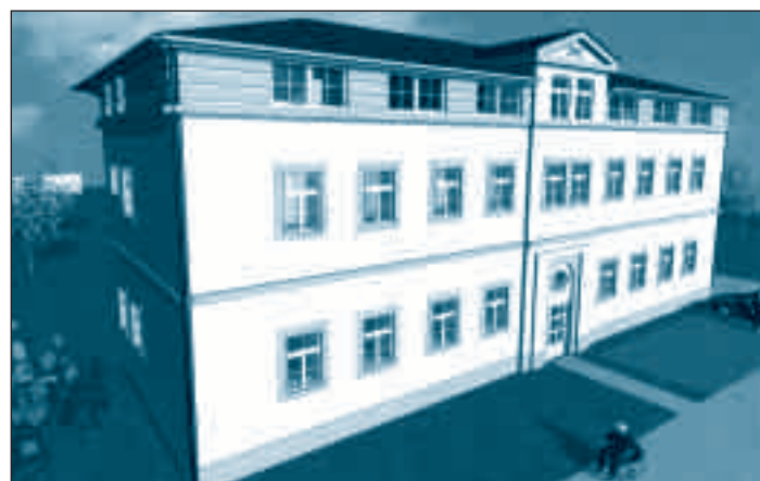
▲ Pod střechou domu pro seniory přibudou okna podkrovních bytů a celá budova dostane novou fasádu.
