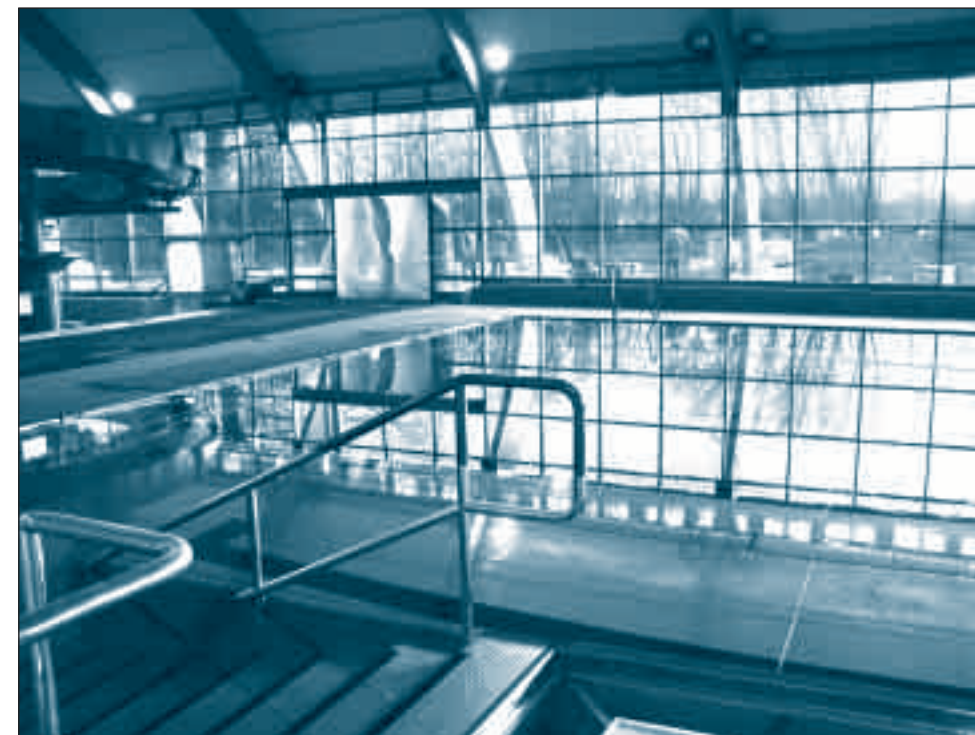
▲ V bazénu už je v této chvíli napuštěna voda a v interiéru finišují dokončovací obkladačské práce
