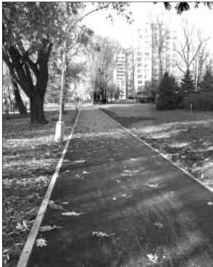
▲ V termínu byla dokončena první část rekonstrukce chodníku, který spojuje obě části Nerudovy ulice. Zbývajíc část ze zámkové dlažby bude předána k užívání v polovině listopadu.
