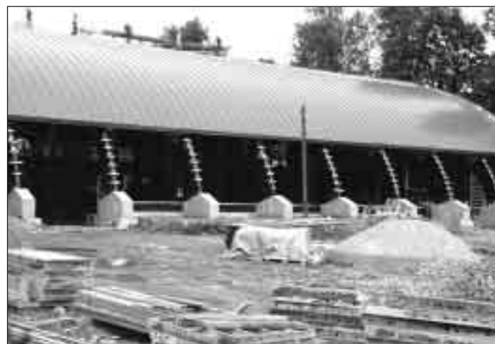
▲ Stavba bazénu doslova roste před očima. Tento pohled zachytil náš objektiv 10. června 2004
